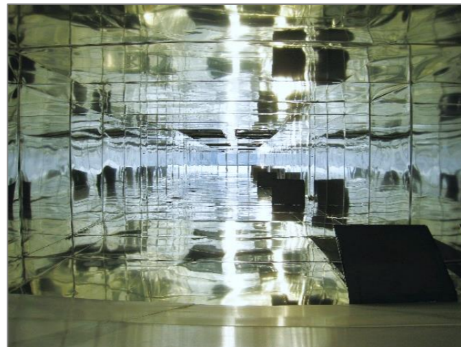
図. 光ダクト設置時の内部の様子
